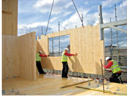
Çapraz lamine kereste (CLT) panelleri fabrikada istenen ölçülerde kesiliyor ve inşaat sahasında monte ediliyor.
