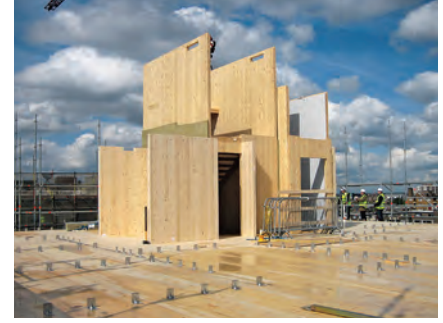
Çapraz lamine kereste (CLT) panelleri fabrikada istenen ölçülerde kesiliyor ve inşaat sahasında monte ediliyor.
