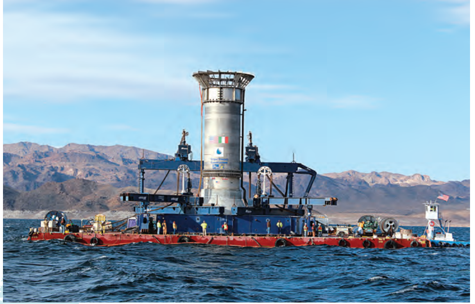
△ 2012'de ekipler Mead Gölü'ndeki bir şamandıra üzerine içi boş bir platform inşa ettiler ve bunu da suyun 90 metre altına yerleştirdiler.
